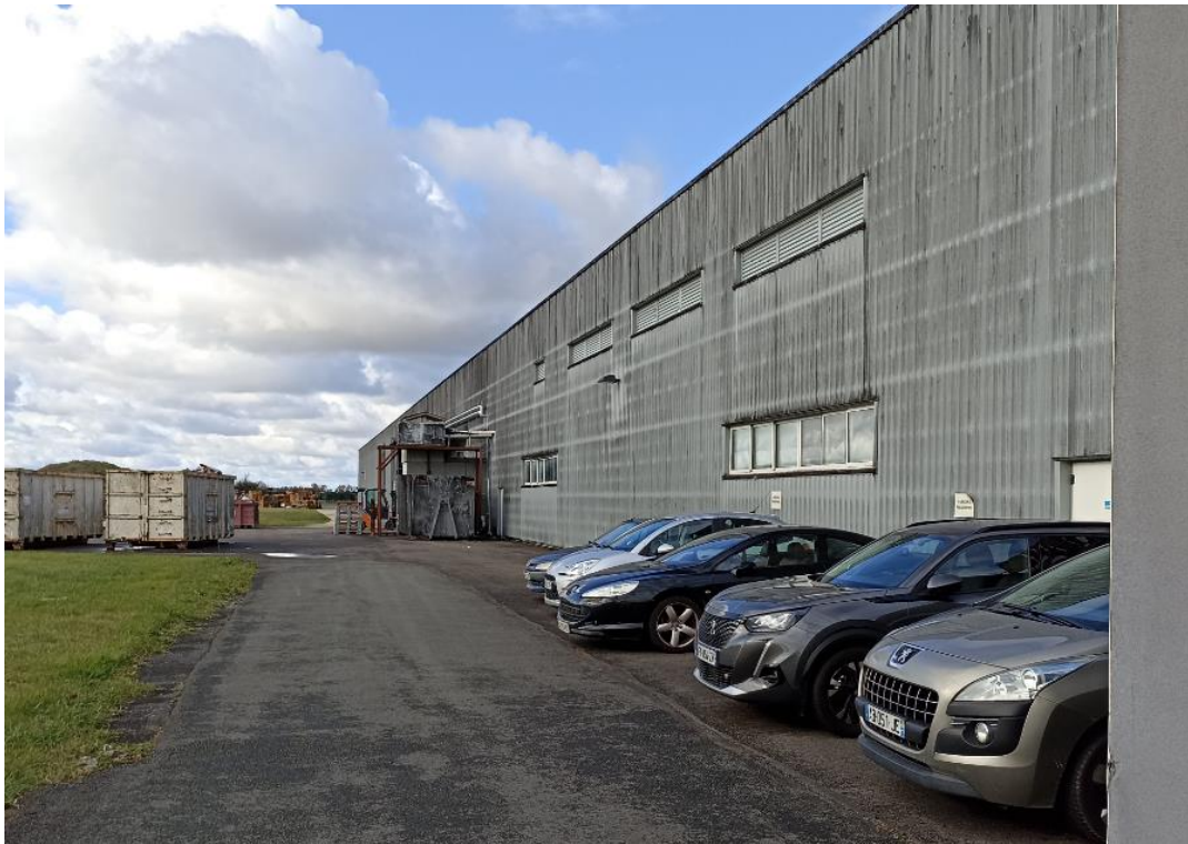
Figure 7 : Façade sud du bâtiment usine.
